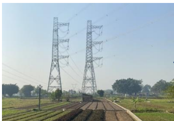
Đường dây 500kV
